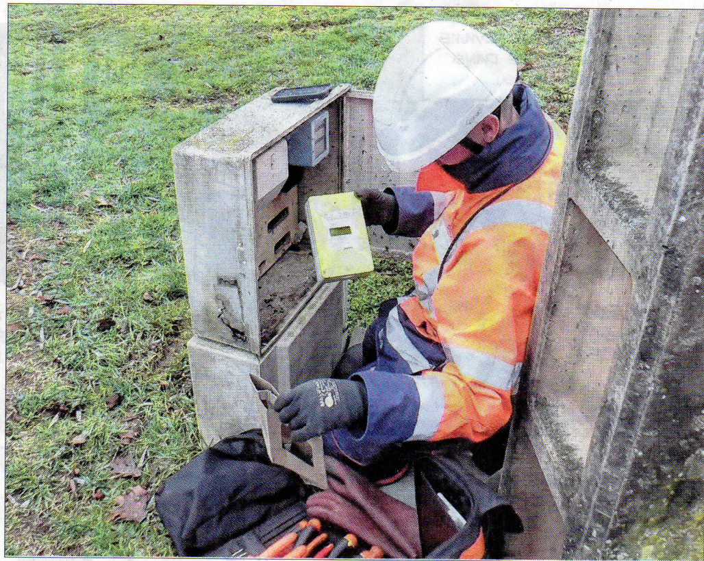
Pose de compteur Linky. Photo DNA
